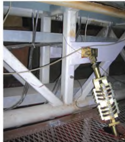
[일반 구조물 진동 저감 시 설치 장면]
