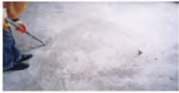
① 바닥 정리작업 및 먹줄긋기
